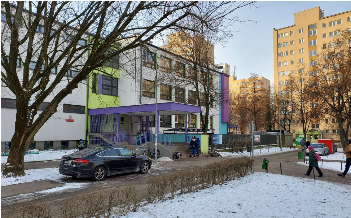
Ilustracja 8. Wejście do Szkoły Podstawowej nr 351 przy ul. Krępowieckiego w Warszawie. Przykład sytuacji trzeciej – miejsca, gdzie zaprojektowano dojście po ciągach pieszych, które obecnie zajmują samochody.
