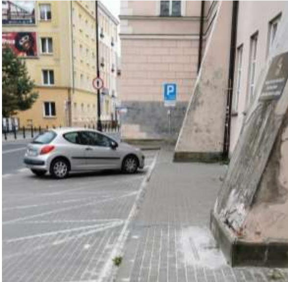
Zdj. Chodnik ograniczony przyporą
