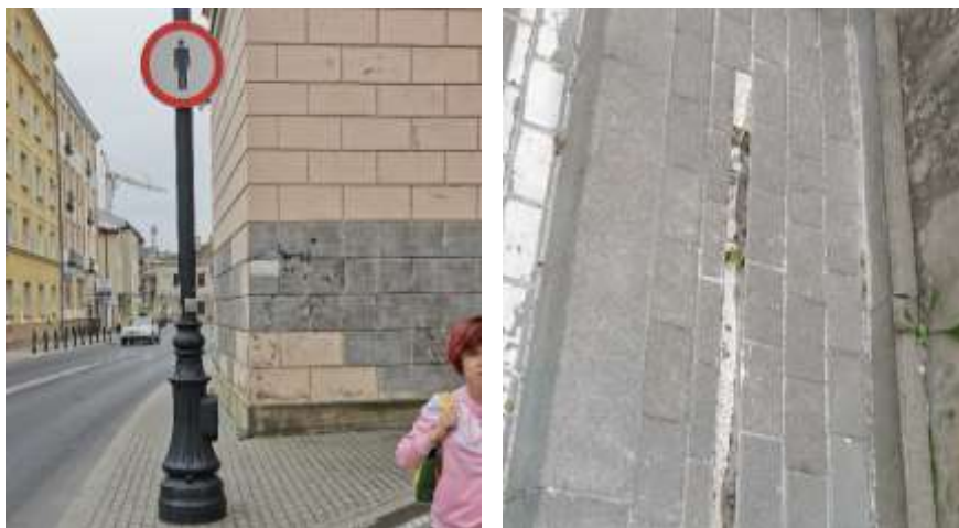
Zdj. Niewidoczny zakaz ruchu / Dziura w chodniku, pozostałość po oświetleniu
