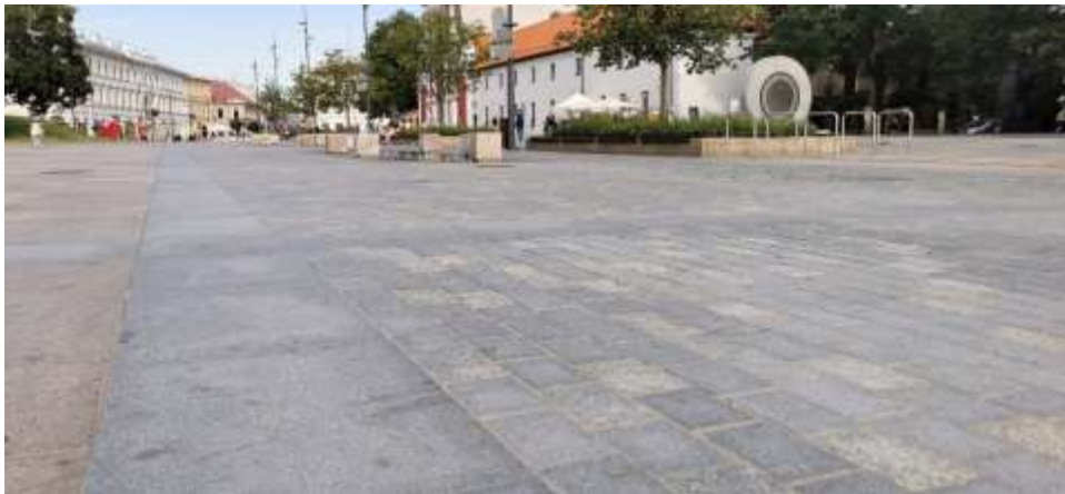
Zdj. Nawierzchnia, pl. Litewski
