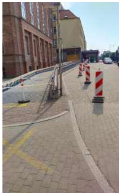
Zdj. 2 Podjazd dla wózków do szpitala
