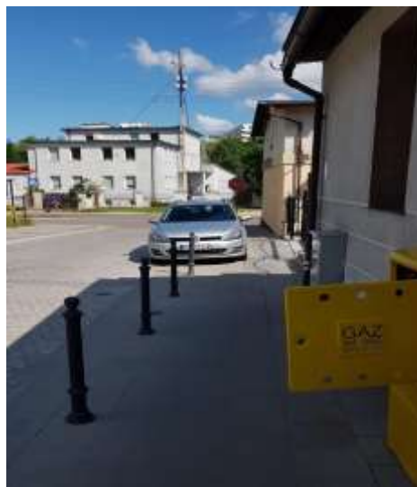
Zdj. 23 Wylot ul Ujeścisko na ul. Kartuską
