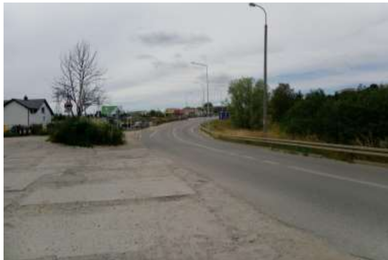
Zdj. 26 Wylot ul. Czereśniowej kier. al. P. Adamowicza
