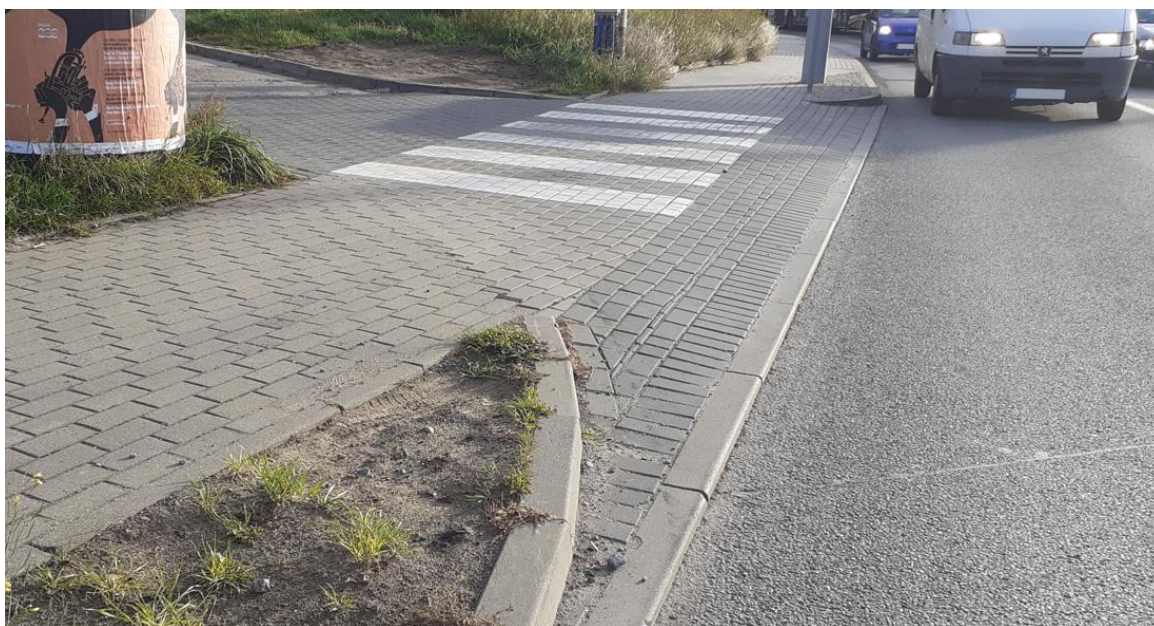
Rysunek 23 Przykład chodnika przejezdnego z najazdem jednostronnym (bez wyznaczania przejścia w ciągu chodnika) zdjęcie: zasoby własne Wydziału Inwestycji – UM Gdynia
