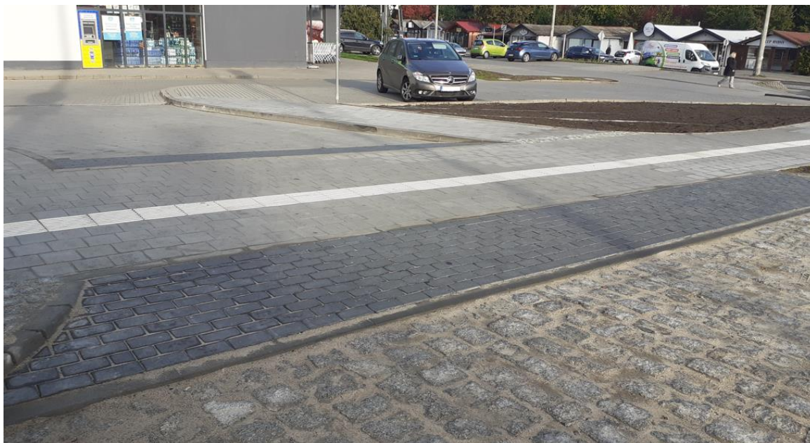
Rysunek 22 Przykład chodnika przejezdnego z najazdem obustronnym zdjęcie: zasoby własne Wydziału Inwestycji – UM Gdynia
